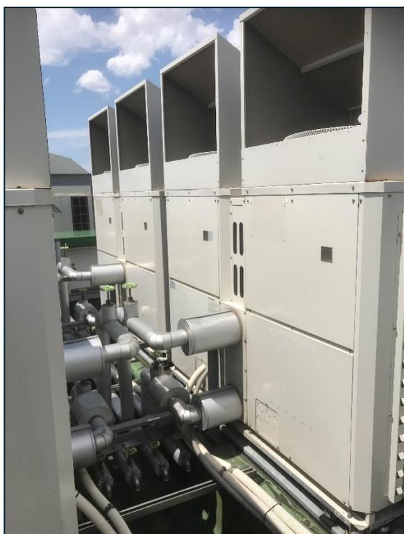
ホットウォーターチラーとは屋上に設置している給湯器です。当施設ではデイサービスや入所されている方の入浴でたくさんのお湯を利用しています。開設から長い間稼働していたため摩耗・劣化が激しく、故障すると入浴サービスの提供が困難となることから、このたび修理することとなりました。
